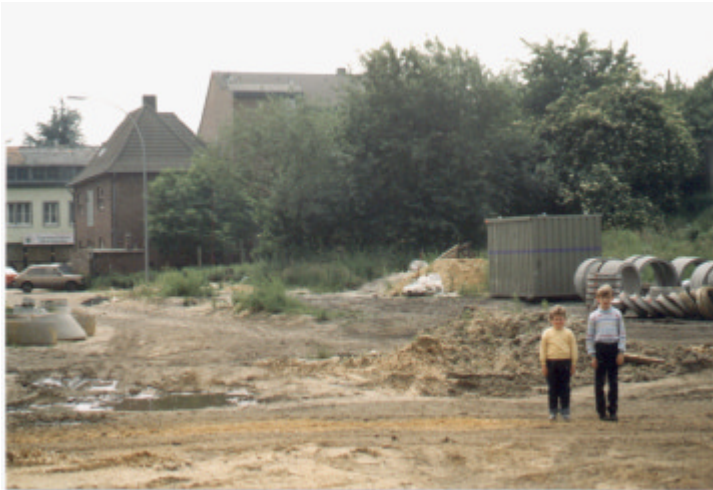
An dieser Stelle steht heute die Raiffeisen-Bank
